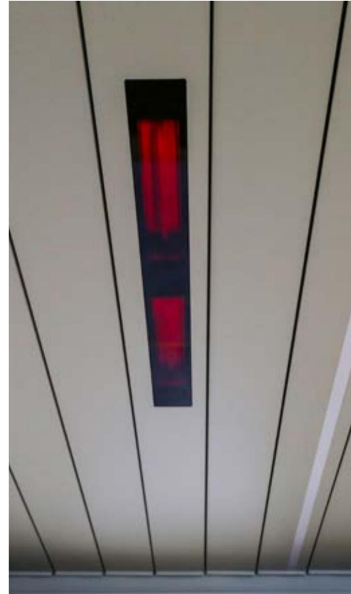
Neu im Sortiment und einzigartig auf dem Markt ist die feste Lamelle mit nahtlos integrierter IR-Heizung. Ausgestattet mit 2 Kurzwellen-Infrarotlampen von 700 W. Genießen Sie eine sofortige Wärmeverteilung und angenehme Strahlungswärme.
